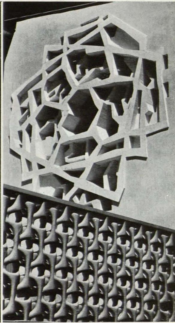
*Detalles del rosetón de hormigón y del muro de cerramiento, con elementos prefabricados asimismo de hormigón.*
