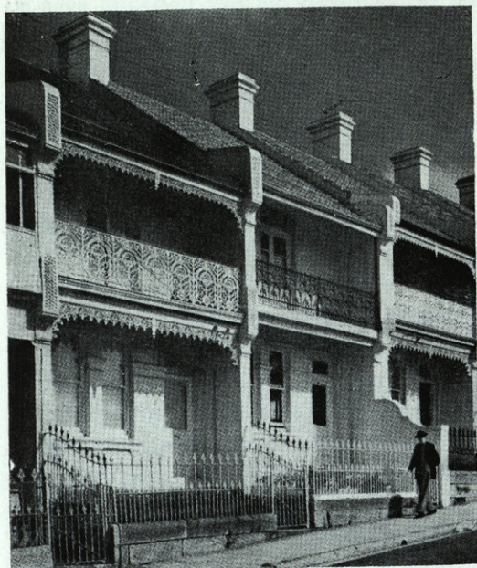
CASAS EN SIDNEY, AUSTRALIA. DISPOSICION DE TERRAZAS EN FACHADA PARA EL CONTROL DEL SOL.
