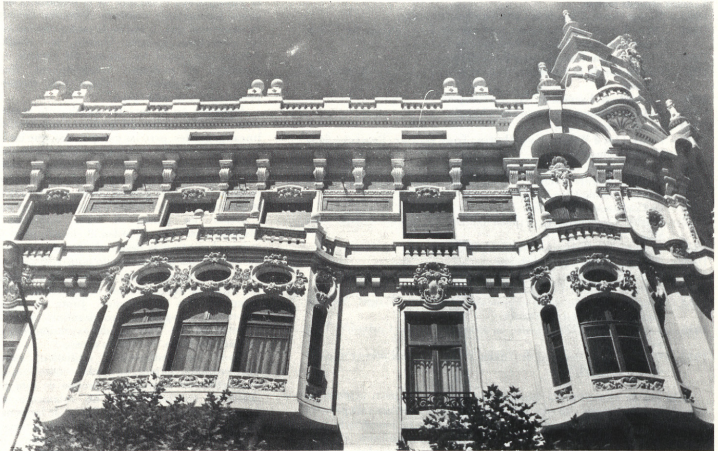
Edificio en Madrid en el cruce de Alfonso XII y Montalbán (1916). Arq: José Luis Oriol
