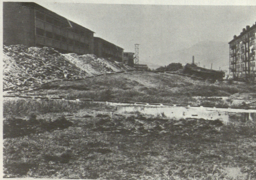
NIVEL DESPUES DESLIZAMIENTO
