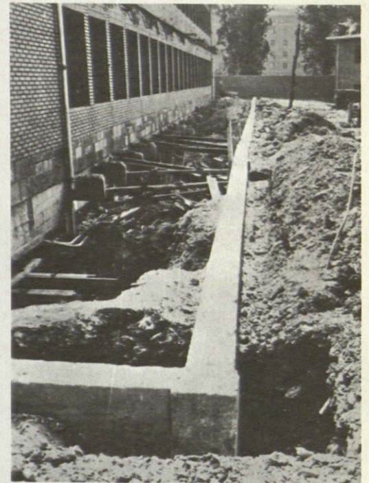
Viga deformada por desplazamiento lateral de un relleno.
