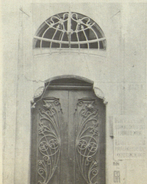
"ART NOUVEAU" PUERTA DEL MISMO EDIFICIO NUM. 3. C/CONCEPCION
