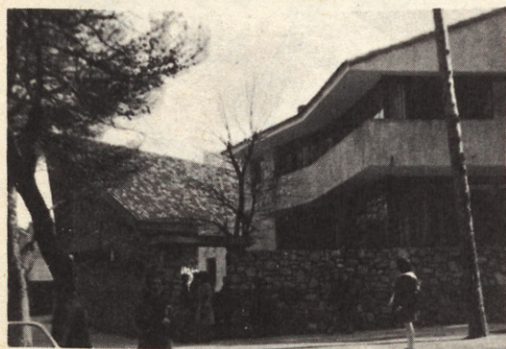
Exterior con las unidades escolares
