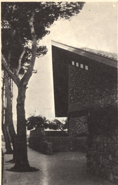
Plataforma de entrada
