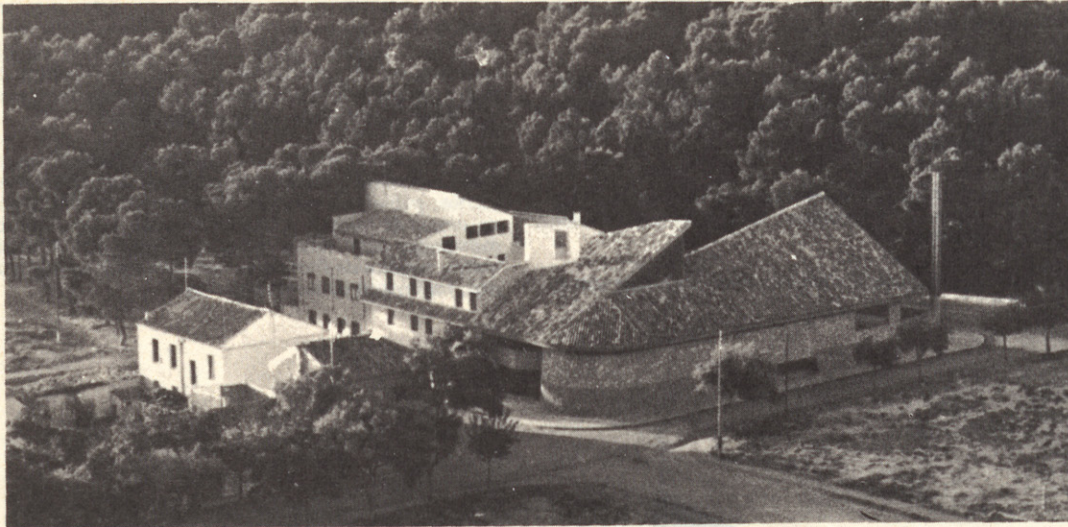
Vista del conjunto desde un edificio próximo
