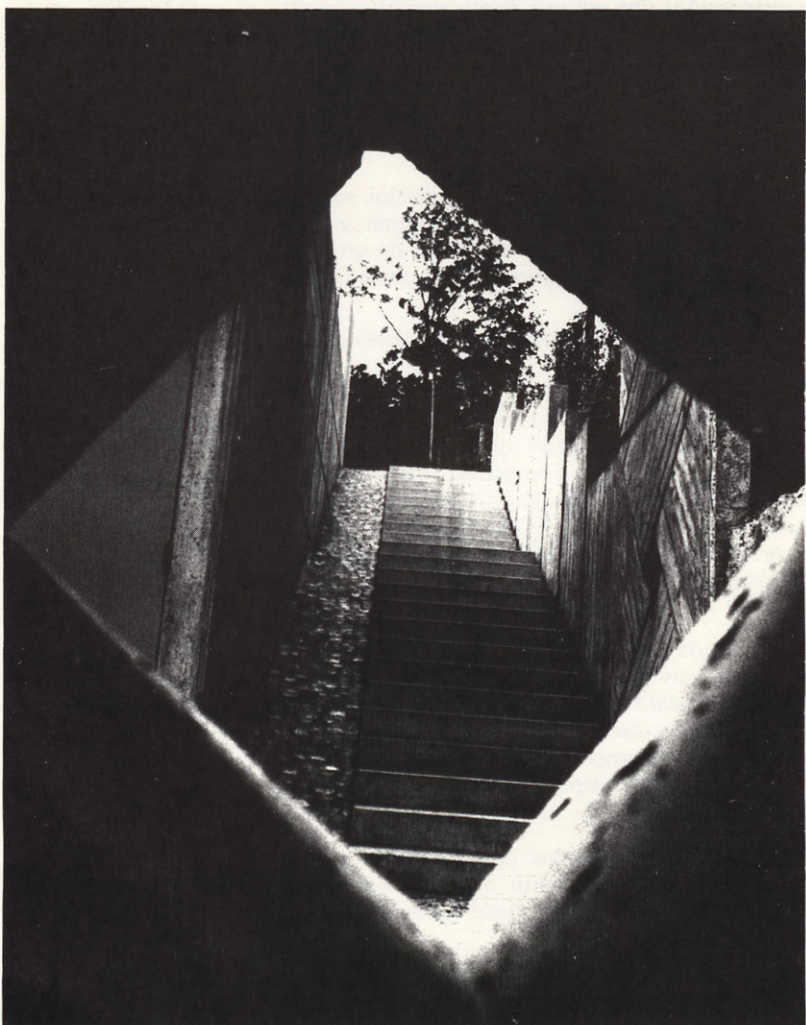
Escaleras al exterior al lado de la central térmica.
