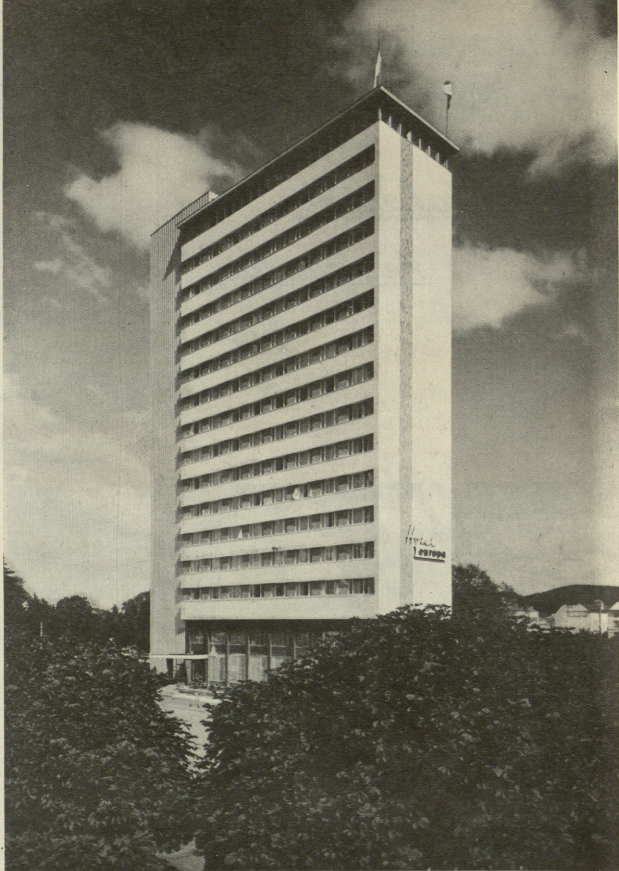
Hotel EUROPA en Salzbourg (Austria) Muros con bloques DURISOL de 30 cm.
