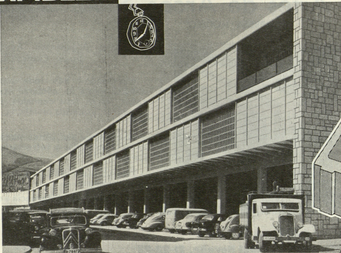
Edificio destinado a la FERIA de Muestras, en Bilbao. Arquitectos: D. Jesús de Basterrechea Aguirre, D. Francisco Hurtado de Saracho y D. José Chapa Galíndez
