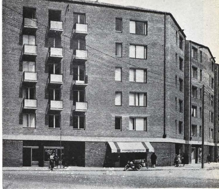
*Vista general del bloque desde el chaflán S. Paramentos de ladrillo. En planta baja, ladrillo barnizado. Bajantes cerámicas. Remate de la cubierta con "tortugada" Balcones (sólo en la orientación S.) de hormigón y barandilla de hierro y baldosilla armada.*
