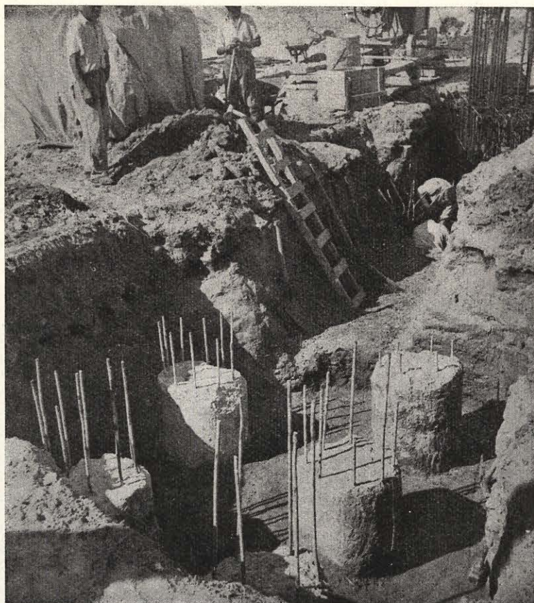
Grupo de 5 PILOTES RODIO para una carga centrada de 450 toneladas.
