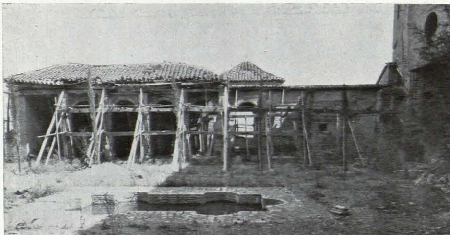
El patio de Machuca. Vistas antes y después de la restauración.
