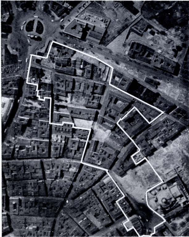
La zona de la reforma, años antes de iniciarse las obras. La labor de rescate se nota ya en alguna de las calvas surgidas por el derribo de edificios ruinosos.
