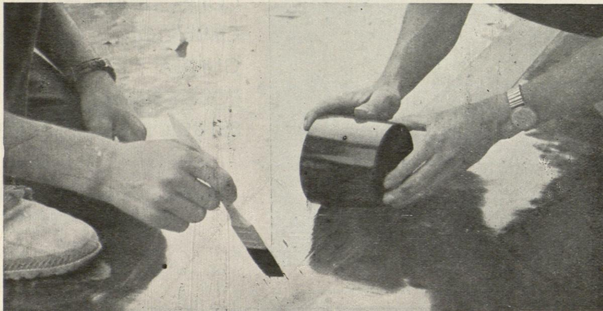
**PROPIEDADES** La hoja NOVANOL constituye una perfecta impermeabilización de cubiertas debido a su estabilidad a la acción del tiempo, a su elasticidad permanente y a poseer una gran resistencia al impacto y a la rodadura. Las cualidades de la hoja, unidas a una técnica de soldadura idónea desde un punto de vista mecánico y de facilidad de realización, nos permiten obtener un revestimiento impermeable de cubiertas o de compartimentos estancos de absoluta garantía
