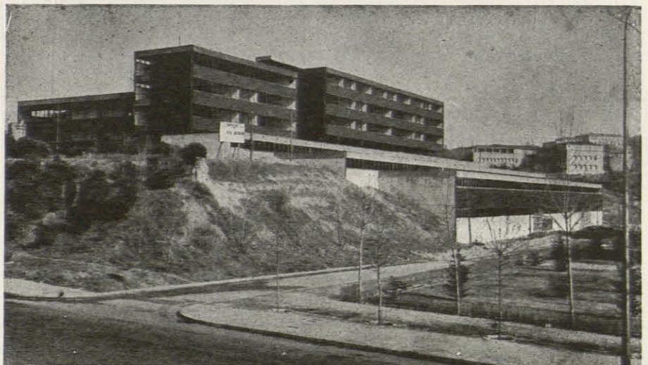
Edificio para Escuela Especial de Ingenieros de Telecomunicación Ciudad Universitaria (Madrid).
