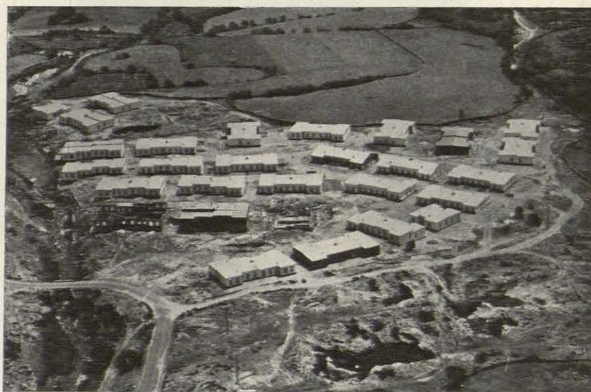
Chalets en Becerril de la Sierra (Madrid) 7.000 m. 2 con lámina DACHAL S-10
