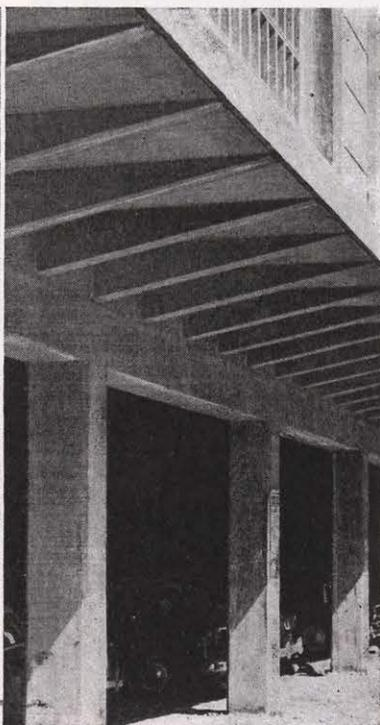
El forrado interior del encofrado de madera proporciona un perfecto acabado en la construcción de hormigón
