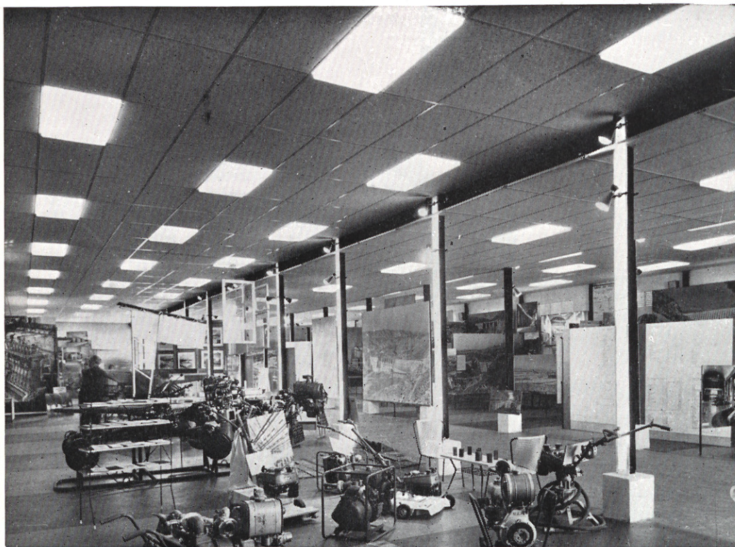
PANTALLAS DIFUSORAS SOBRE TECHO DE "ULTRACOUSTIC" PABELLON DEL I.N.I. EN LA EXINCO
