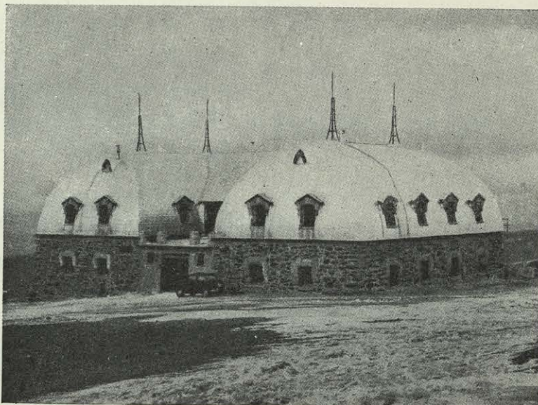
Albergue de Sierra Nevada, Granada. Impermeabilizado con lámina DACHAL, S-10.
