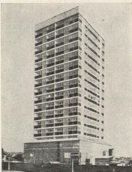
Utilización del sistema 'Jackblock' en Coventry. Construcción en dirección ascendente por medio de línea de montaje a nivel del suelo.
