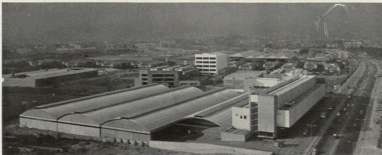
Vista de dos cubiertas realizadas con plancha SUPERONDA y con SUPERONDA curvada respectivamente.
