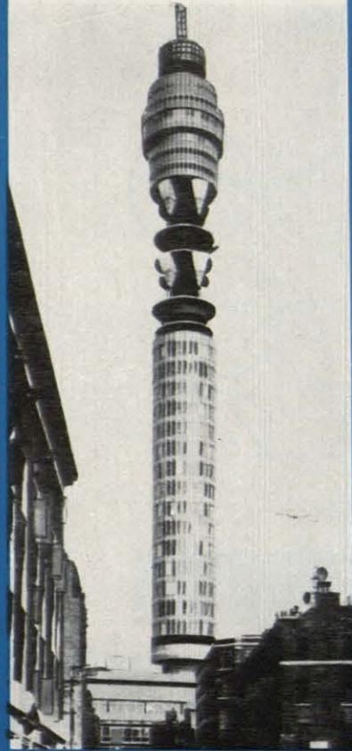
TORRE DE RADIO GPO - LONDRES Arquitectos: Arquitecto Jefe de la División del Ministerio de Edificios y Obras Públicas. (Foto cortesía de HM Postmaster General)
