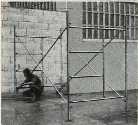
3.ª Fase 2.ª y 3.ª Fase: Fijación del conjunto por medio de las crucetas.
