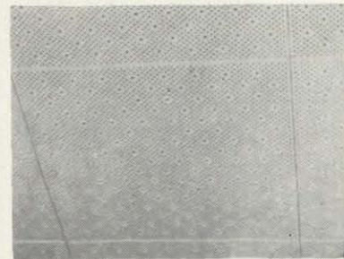
Panel SOUNDEX SANI-JET desmontable, aislante, termo-acústico estudiado especialmente para acondicionamiento de aire por el sistema de "plenums"
