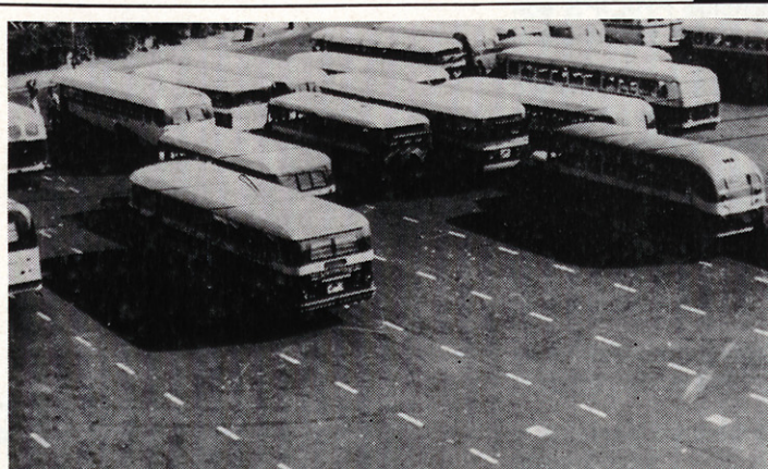
Una estación terminal de autobuses en Sud Africa está asfaltado con una composición de resinas Epikote (Epidermix). El área de aproximadamente 5.000 m 2 de superficie no muestra ninguna señal de desgaste ni deformación después de 3 años de constante movimiento.
