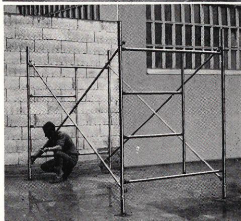
3. a Fase 2. a y 3. a Fase: Fijación del conjunto por medio de las crucetas.
