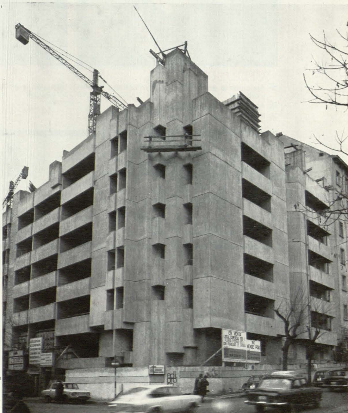
Edificio de Apartamentos en Madrid. (En construcción.)
