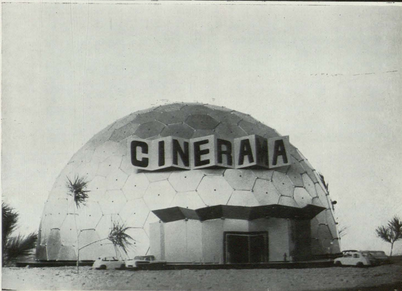
MAQUETA DE UNA SALA Y VESTIBULO PARA PROYECCIONES POR EL SISTEMA CINERAMA, RESUELTO CON CUPULAS POLIEDRICAS. LOS ELEMENTOS RESISTENTES INCLUYEN LA CUBRICION.
