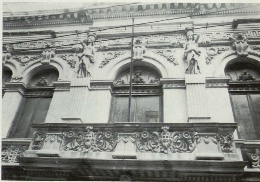
CASINO DE MURCIA. FACHADA.
