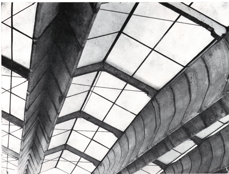
Cubiertas de naves industriales con vigas postesadas prefabricadas por Dovelas
