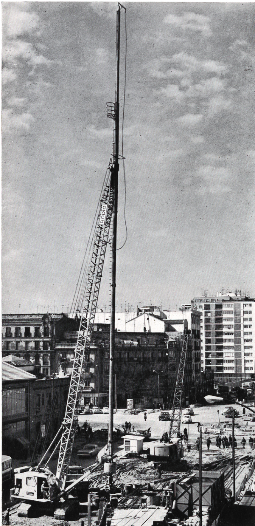
Glorieta Cuatro Caminos, Madrid. Paso superior cimentado sobre PILOTES RODIO.
