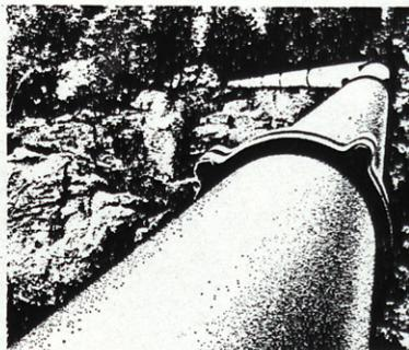
de espesor uniforme y superficies lisas, que no sufre incrustaciones, que mantiene constante su capacidad de conducción y que se instala con gran facilidad. Un
