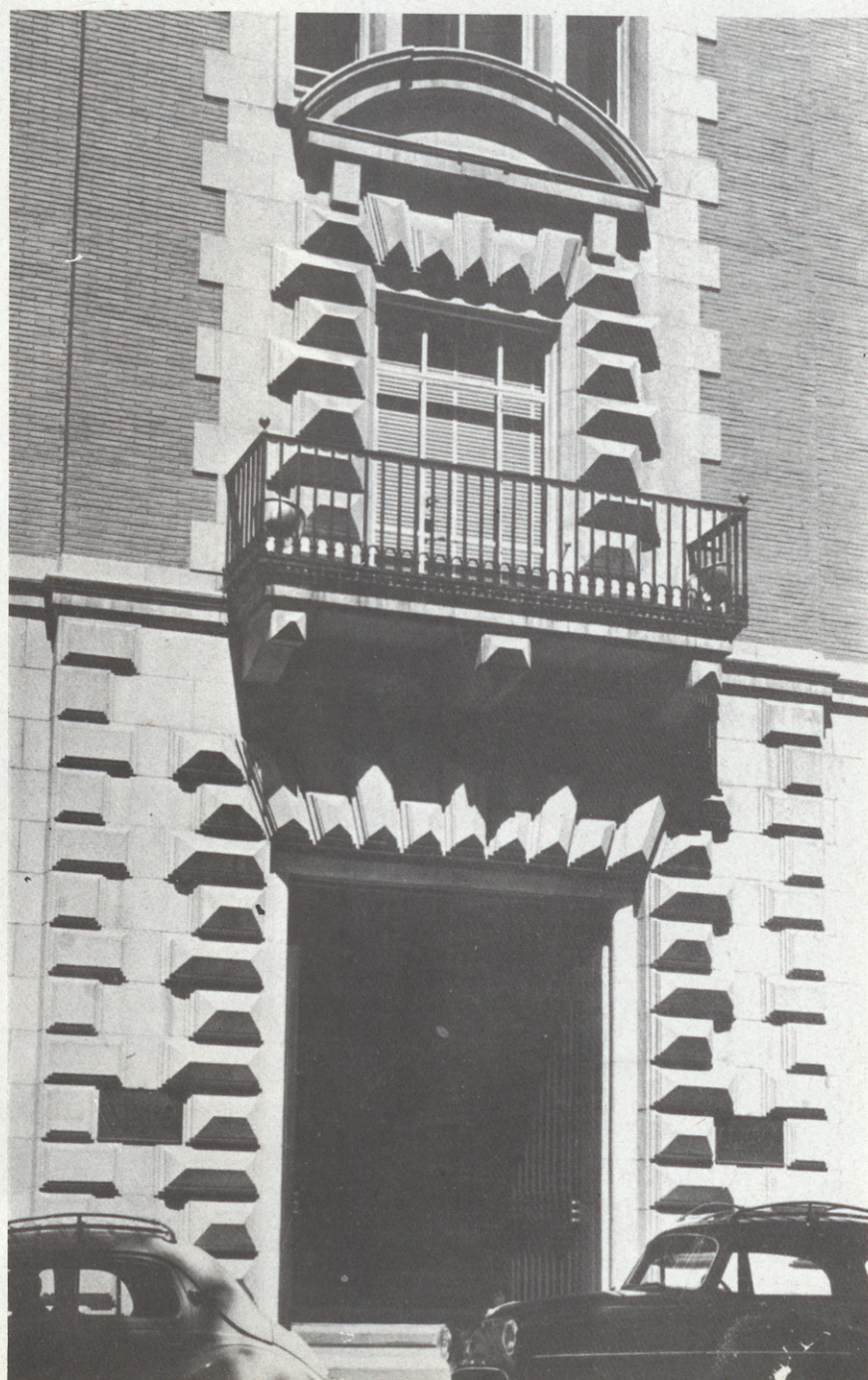
EDIFICIO DE LA CAMPSA en el Paseo del Prado, en Madrid. Detalle de la portada. Año 1952
