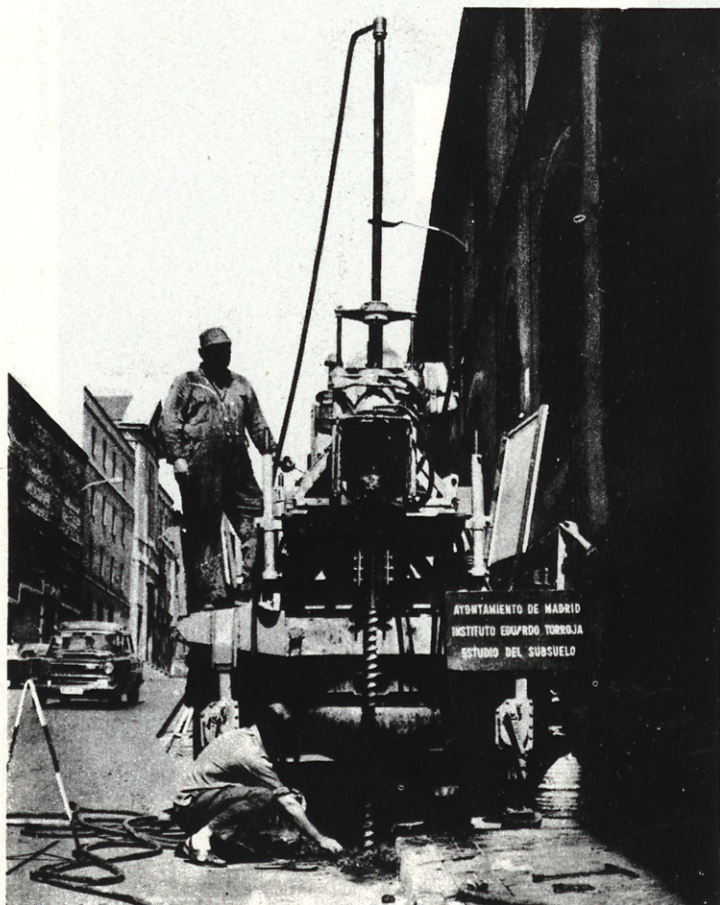
Sondeos efectuados por SIPSa para el Ayuntamiento de Madrid a través del Instituto Eduardo Torroja.
