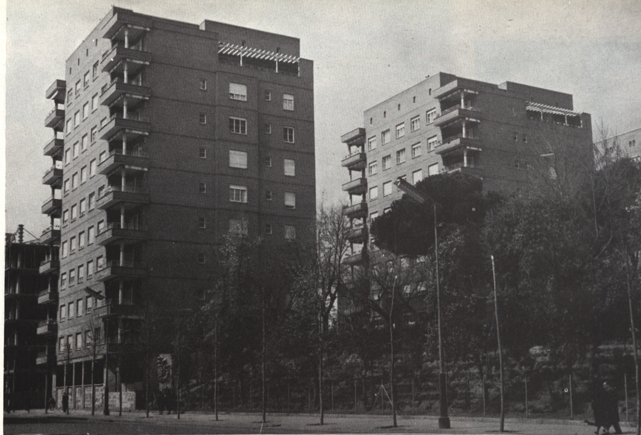
CASA DE VECINDAD en Madrid, calle de Cea Bermudez. Año 1947
