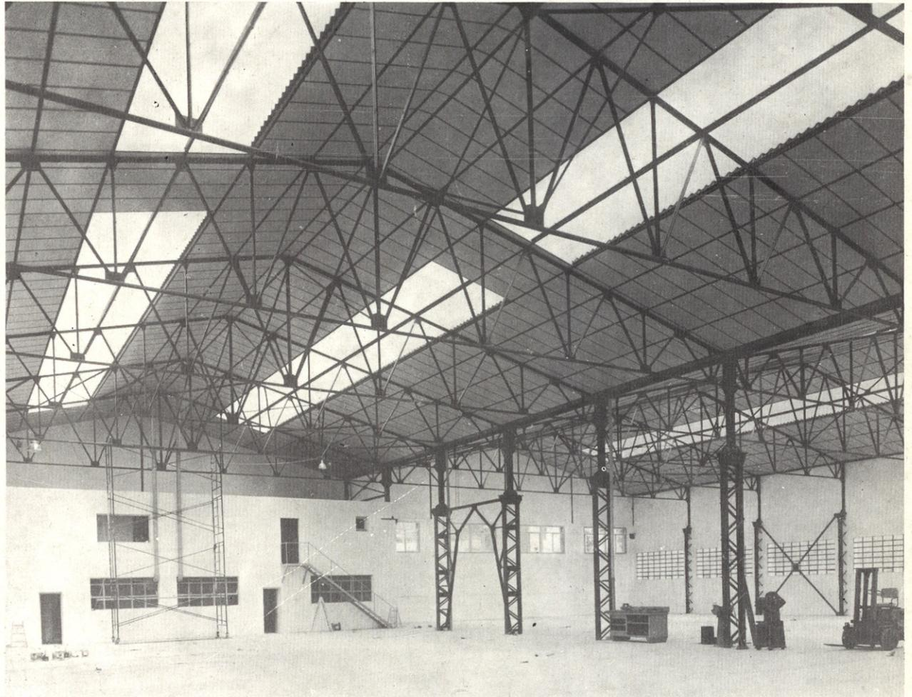
Cubierta de nave en Cirauqui (Navarra), aislada con 1.800 m<sup>2</sup>. de Panel DIN aluminizado. Realizado por Navarra de Aislamientos y Cubiertas (Pamplona)
