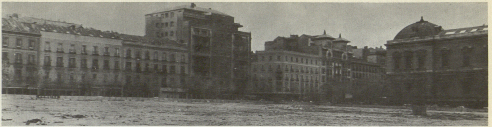
Entre las fachadas de la Biblioteca y la de Serrano, entre Goya y Jorge Juan, únicamente desentona el edificio de la esquina con esta última calle. Tapando las zonas que rebasan la altura tipo en la calle de Serrano, se comprueba cómo el conjunto está perfectamente resuelto.
