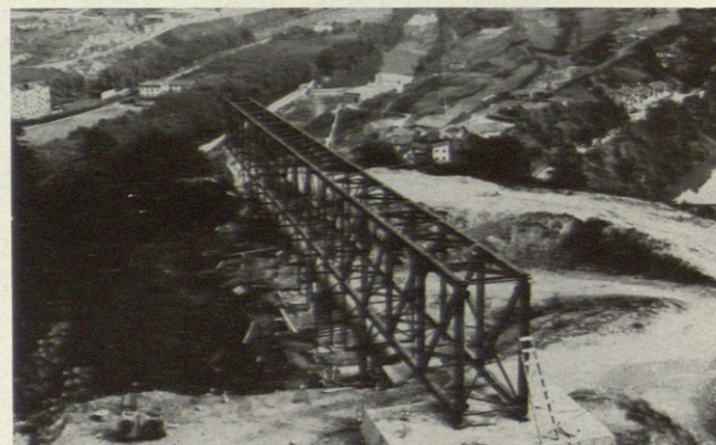
Viga de 64 m. Soporte de la tubería de impulsión de Venta Alta. Bilbao.
