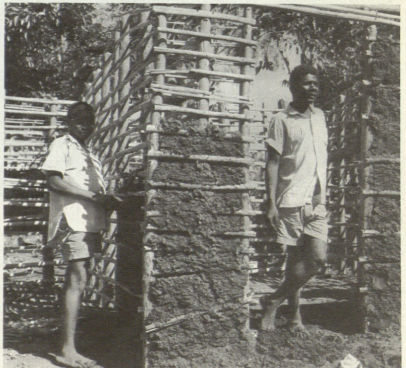
Construcción en bambú y barro Africa del Este (País Malawi).
