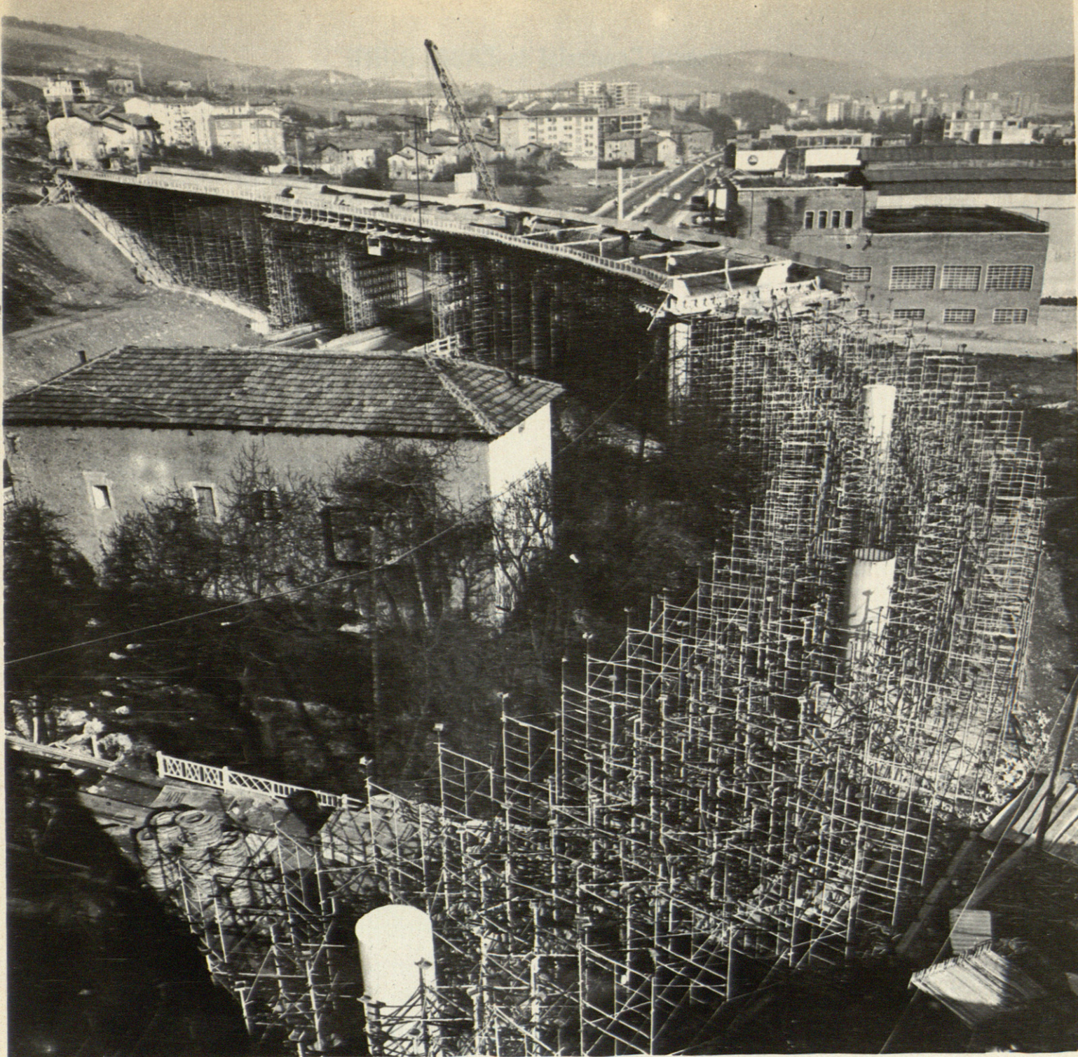
AUTOPISTA BILBAO-BEHOBIA • Complejo de apuntalado para LAING-IBERICA
