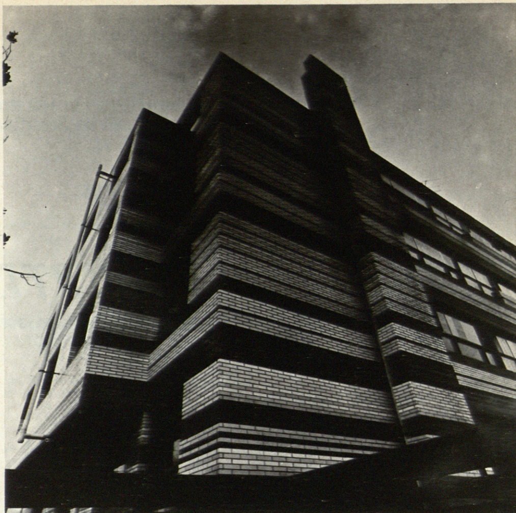
Edificio de 16 viviendas de lujo en NEGURI (VIZCAYA), construido por esta firma.
