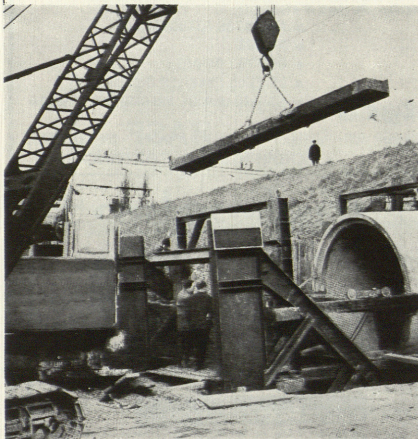
TUNEL PREFABRICADO SIN INTERRUPCION DE TRAFICO
