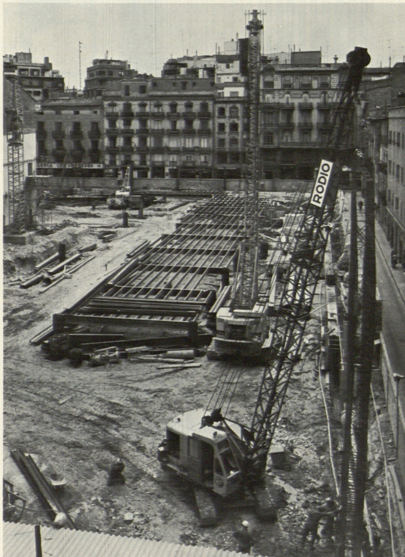
Edificio "El Corte Inglés" - Valencia Pantalla continua y pilotes de gran diámetro
