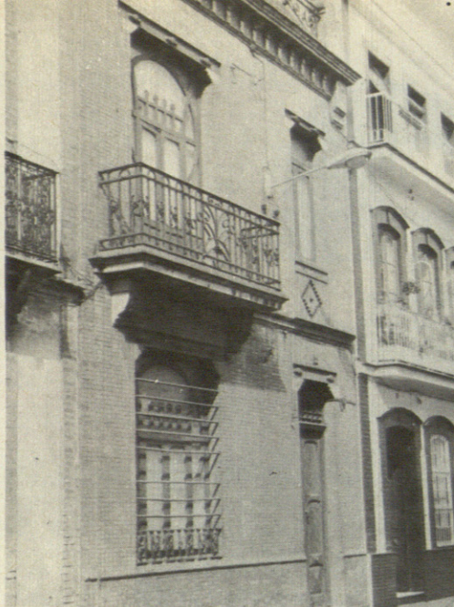
"ART NOUVEAU" EDIFICIO EN CALLE QUEIPO DE LLANO HUELVA.
