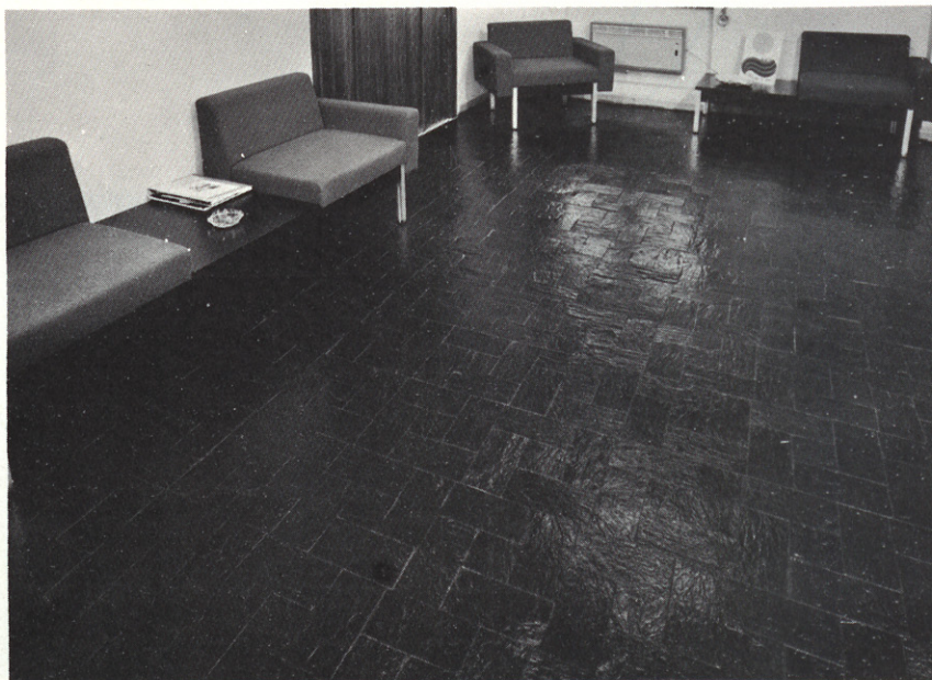
Solado con pizarra, en el vestíbulo de una oficina
