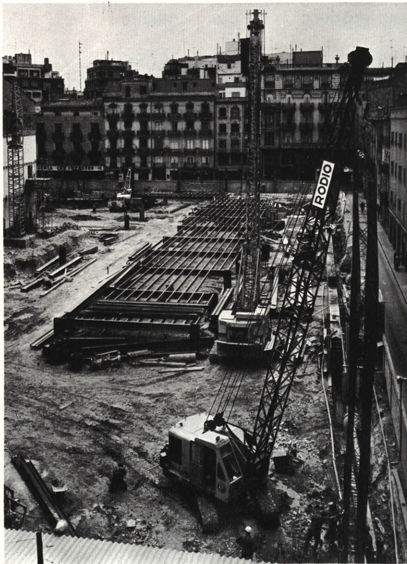
Edificio "El Corte Inglés" - Valencia Pantalla continua y pilotes de gran diámetro
