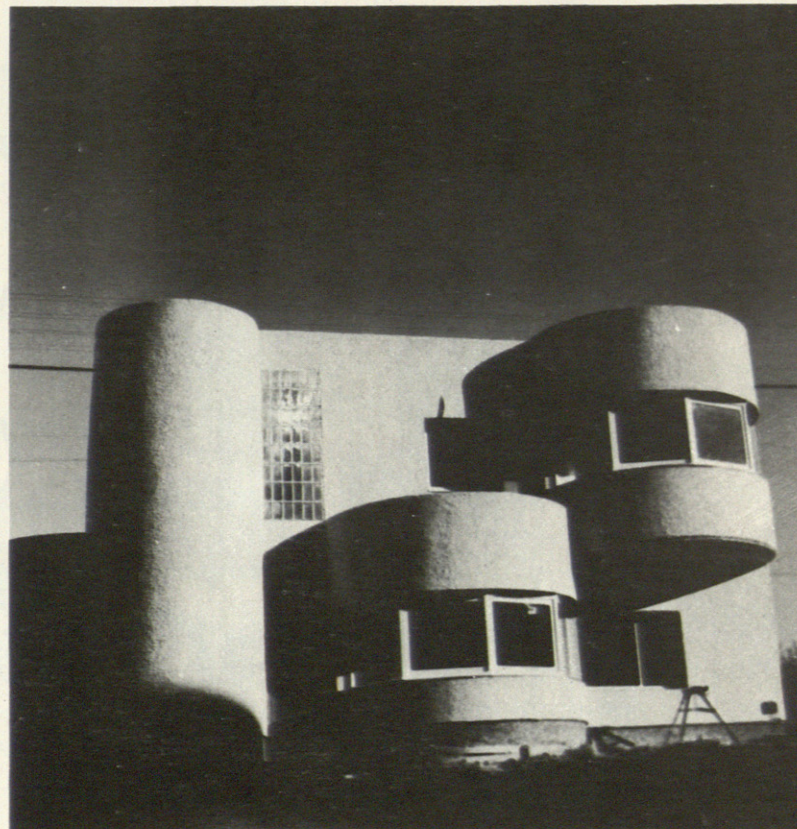
Dos aspectos de las fachadas de la Residencia de Cuenca.
