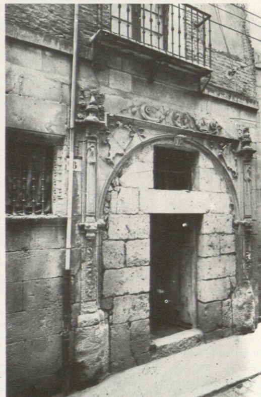
Portada del edificio núm. 4 de la calle Fernán González (Paulino Orejón).
