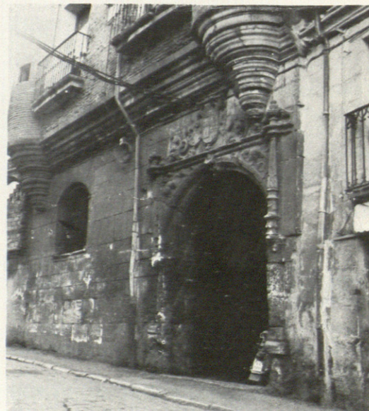
Detalle de la entrada principal.
