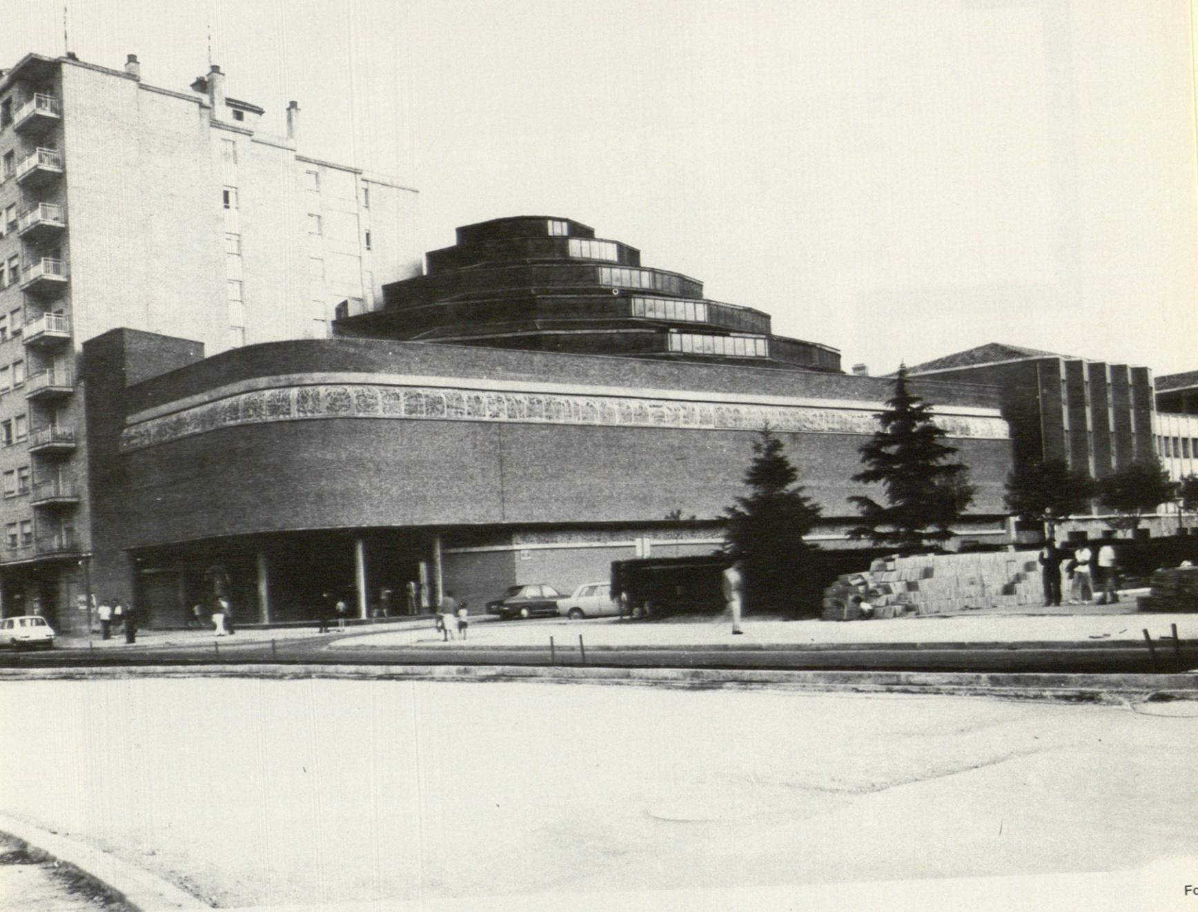
Ejecutada en el año 1.966. El solar en esquina, con medianería en ángulo recto, dió lugar a la disposición radial. El desagüe de una cubierta capaz de albergar un espacio importante generó la figura del cono.
