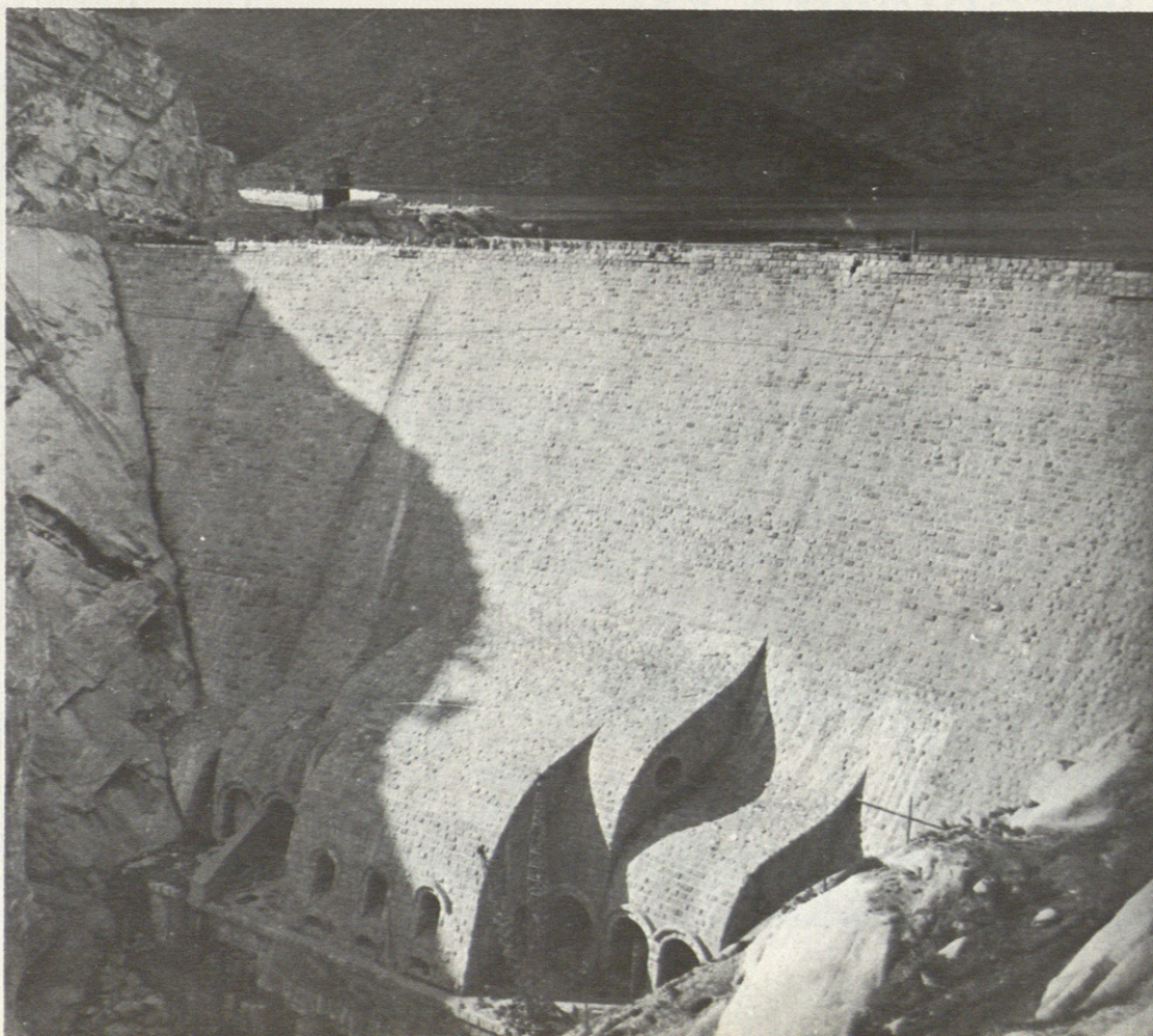
Dos detalles del muro de contención del Salto del Jándula, sobre el río Guadalquivir; obra de C. F. S.
