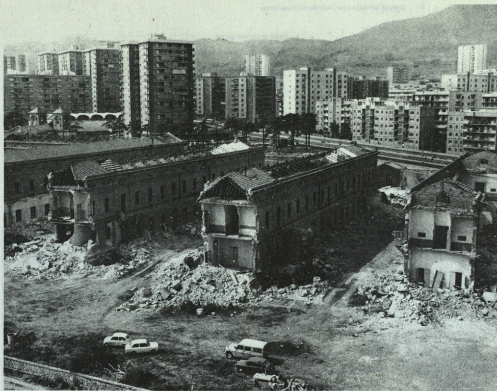
Derribo del Instituto Mental de la Santa Creu en Barcelona y vista del barrio edificado sobre los antiguos terrenos del hospital de S. Pablo derribado en 1961; ejemplo de una política de vivienda respetuosa con las dotaciones.
