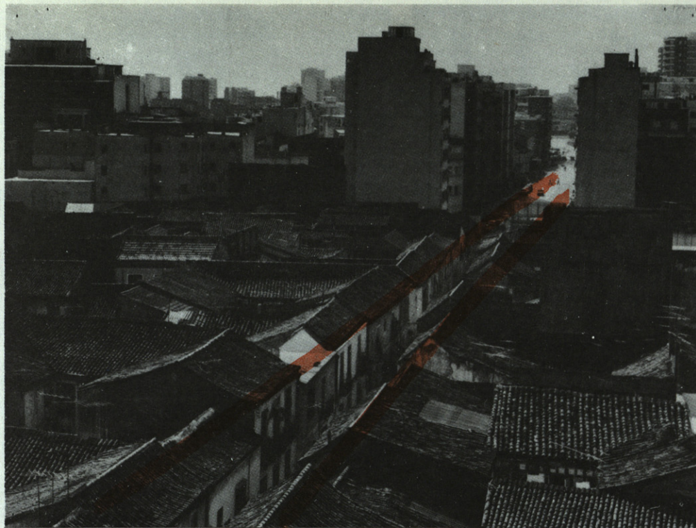
En primer término, la calle Jaboneros, objeto del proyecto de ensanche. El proyecto es justificado por el Ayuntamiento con razones de trazado viario, a pesar de que las medianerías colindantes explican más convincentemente el carácter de la operación.
