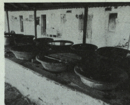
La instalación de lavaderos comunales de la corrala de Santa Sofía.
