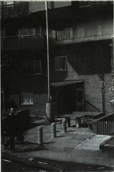
(**) Una de las entradas a un núcleo de escaleras y ascensores del bloque perimetral.
