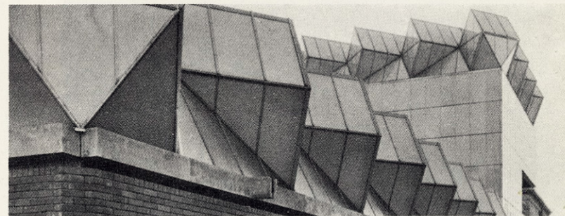
20. Bloque inferior del cobertizo visto desde el Sur. La ranura separa la base de ladrillo de la superestructura de la claraboya.
