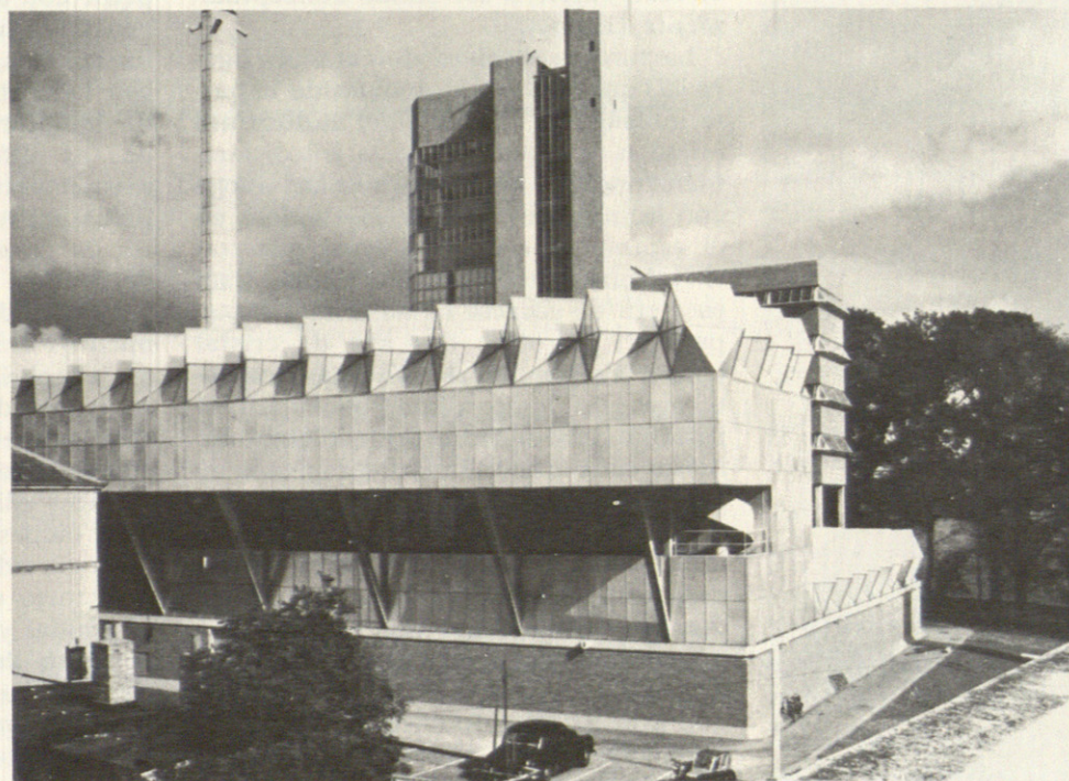
35. Universidad de Ingeniería de Leicester (1963). Arquitectos: James Stirling y James Gowan. Vista desde el sur del cobertizo.
