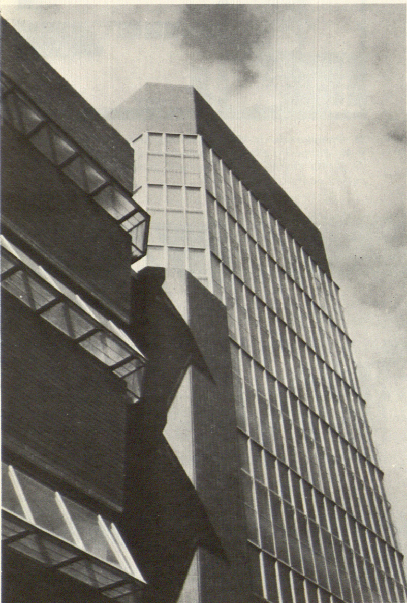
32. Detalle visto desde el Este. A la izquierda, la torre del laboratorio; a la derecha, la torre de oficinas.
