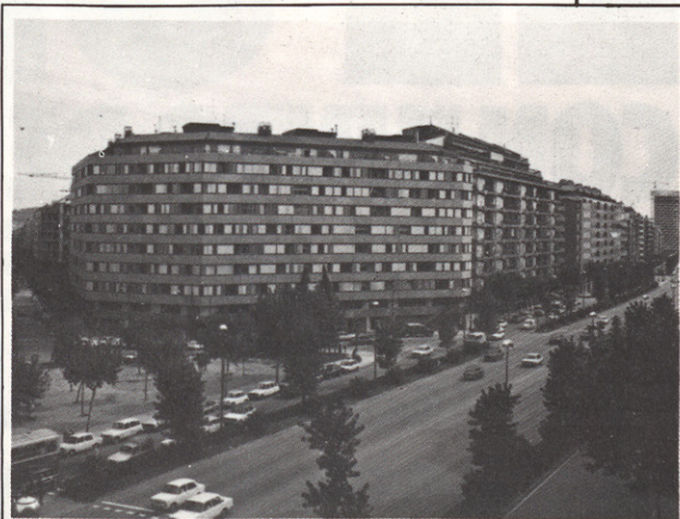
EDIFICIO DE COBASA EN BARCELONA
