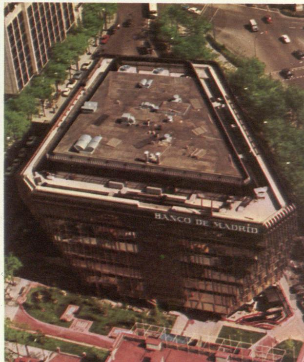
Terraza de 2.500 m.<sup>2</sup> de superficie, recubierta con láminas de caucho butílico INDY, perteneciente al edificio del Banco de Madrid (ahora la Caixa).
