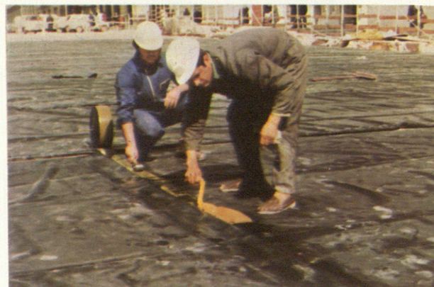
Detalle de empalmado en frío de las láminas. La facilidad de instalación es característica del caucho butílico INDY.
