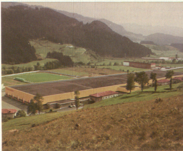
Pabellón industrial en Yurre (Vizcaya), cuya cubierta de m. 2 de superficie, ha sido impermeabilizada con láminas de caucho butílico INDY.
