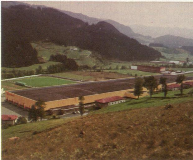
Pabellón industrial en Yurre (Vizcaya), cuya cubierta de 22.500 m.<sup>2</sup> de superficie, ha sido impermeabilizada con láminas de caucho butílico INDY.
